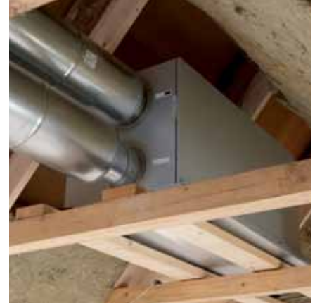
HCH monté en comble
